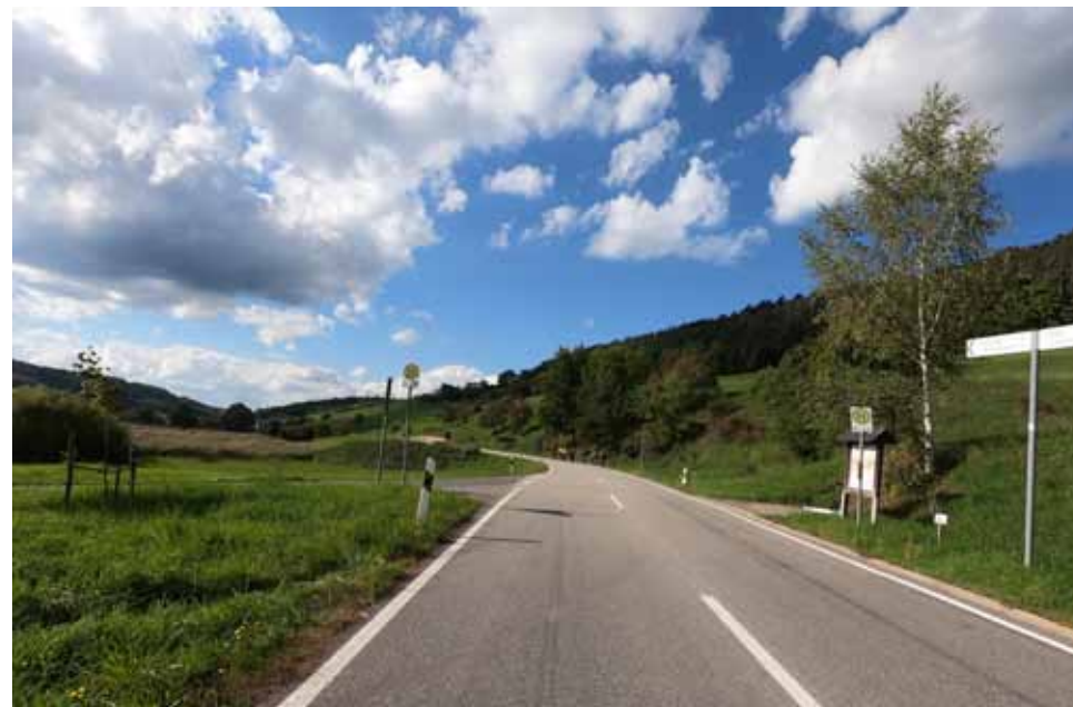
Abb. 6. Nicht für Schulkinder befahrbar: Die L 1062
