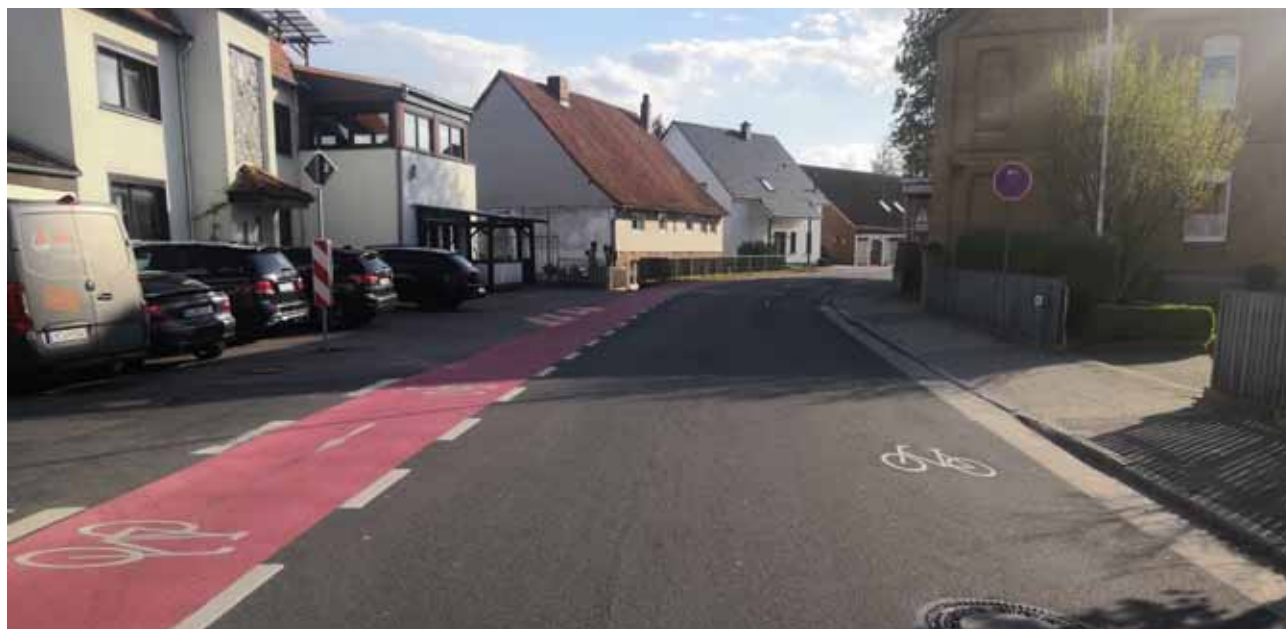
Abb. 44. Beispiel einer Dorfdurchfahrt ohne Mittelstreifen, mit Piktogrammketten und einseitigem Schutzstreifen, Region Hannover
