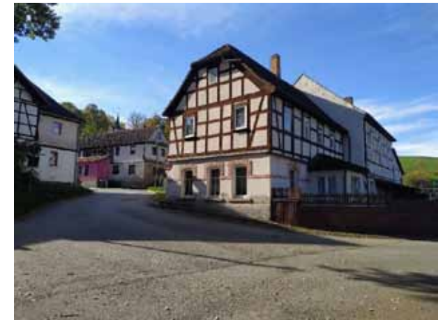
Abb. 38. Uneinsichtige Kurvenlage in RE 2.1
