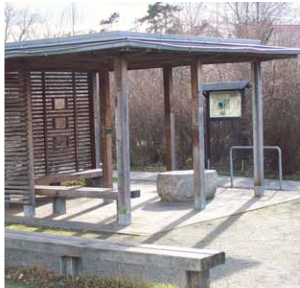
Abb. 51. Rastplatz mit Abstellanlage und Infotafel
