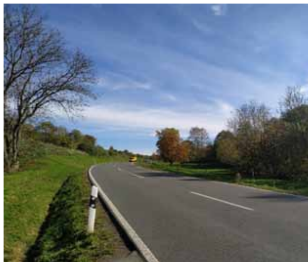
Abb. 29. Landstraße mit Höchstgeschwindigkeit 100 km/h
