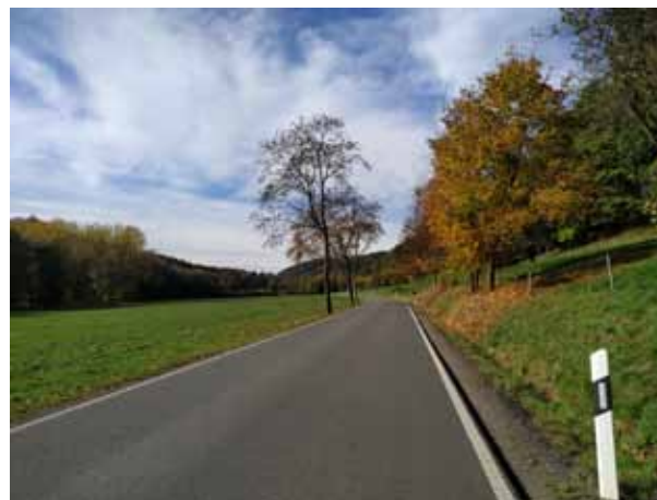
Abb. 19. Fahrbahn außerorts ohne Mittelmarkierung
