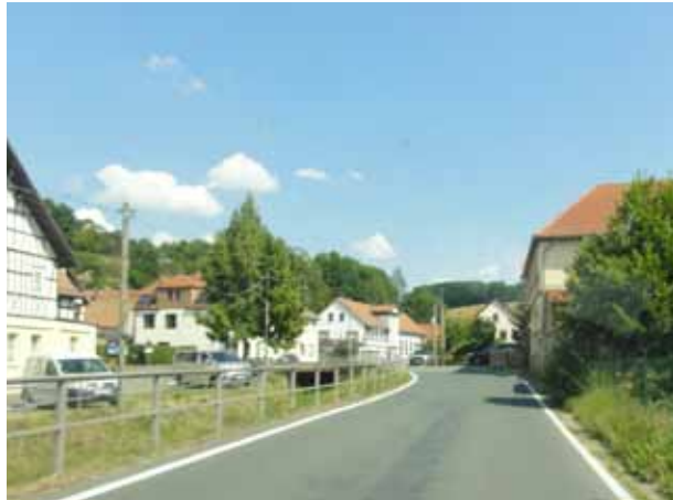
Abb. 39. Beispiel einer Ortsdurchfahrt ohne Mittelstreifen
