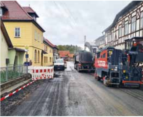
abgefräste Fahrbahn-Oberfläche
